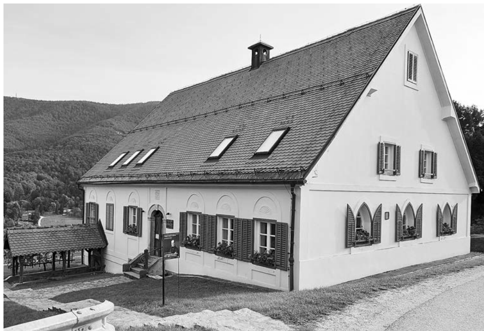
Das renovierte Gebäude des Gutes Meranovo mit einem darunter liegenden Weinkeller
